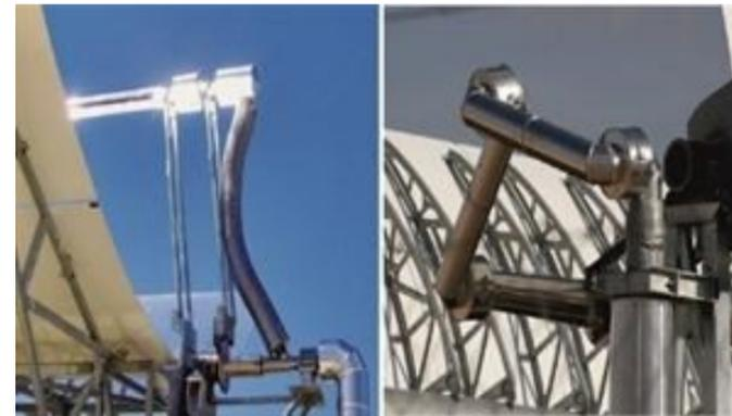
Fig. 6: Exemplos de juntas que permitem a movimentação do absorvedor em coletores parabólicos.
