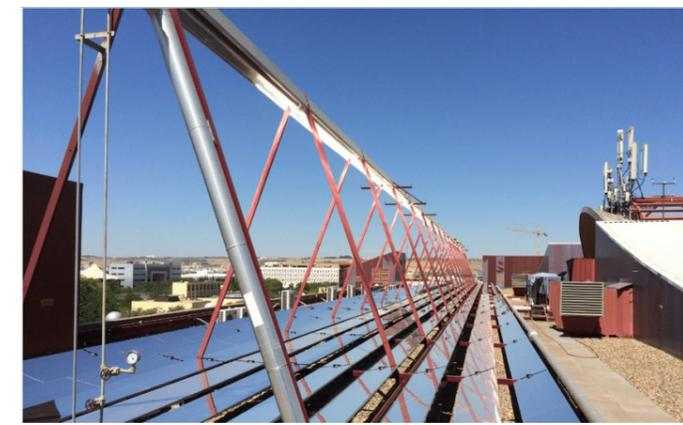
Fig. 7: Coletor de Fresnel no teto da escola de engenharia da Universidade de Sevilla.
