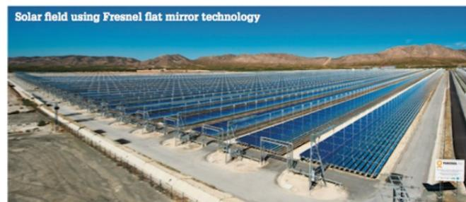
Fig. 5: Exemplo de campo solar com coletores Fresnel.
